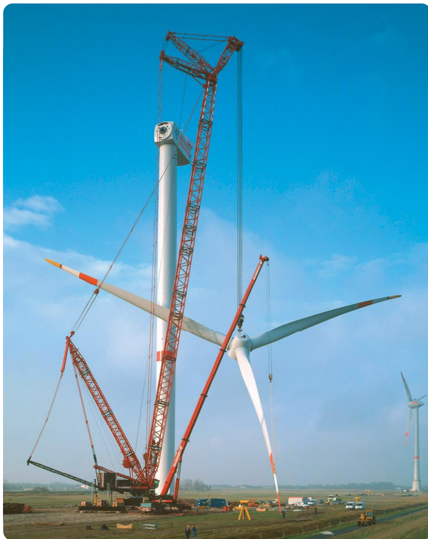
Bild 1: Raupenkran LR11350 bei der Montage einer 5 MW Anlage. Max. Last: Maschinenhaus 329t mit Hakenhöhe 129 m.
