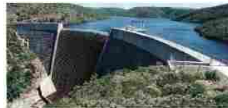
Wolwedans Dam, 1995 erster RCC Dam der Welt (H=70m; L=270m)
